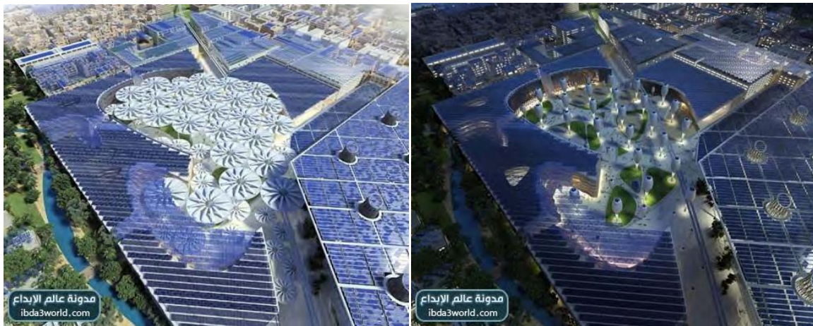
شکل ۸: استفاده از سایه بان های چادری برای استفاده در طول شبانه روز با قابلیت باز و بسته شدن - پانل های جاذب انرژی خورشیدی برای تولید انرژی
